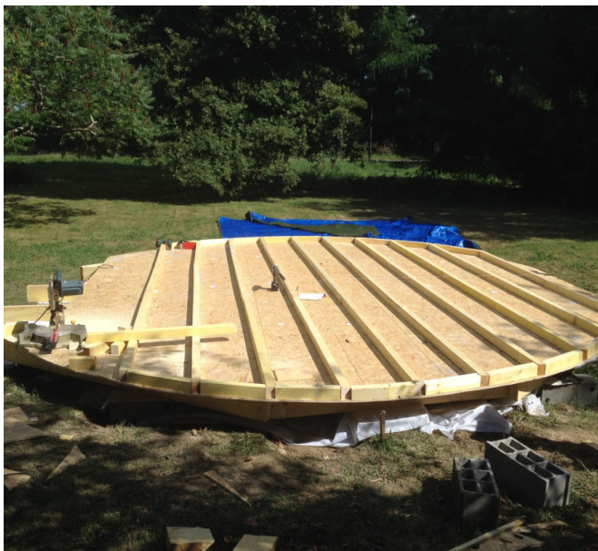
Solivage haut + osb, prêt à mettre l'isolation
