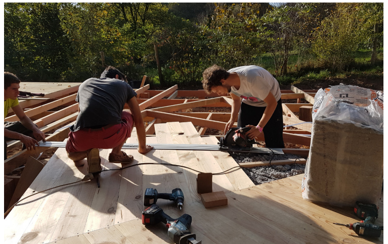
Pose du plancher en étoile (très long à faire, mais très beau)
