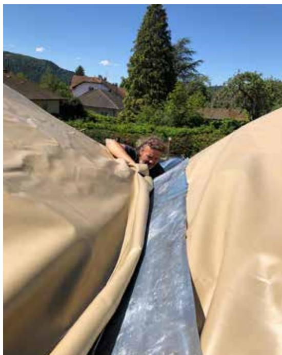
Jonction double yourte avec gouttière sur mesure en zinc
